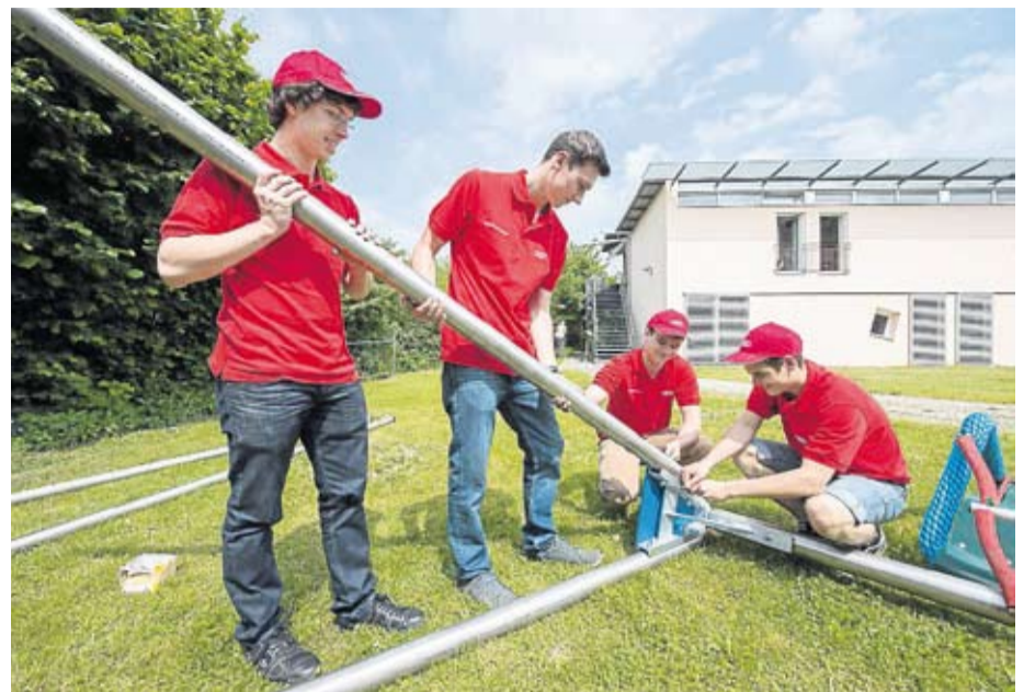
Die Audi-Azubis bauen eine neue Schaukel für die Bewohner der Lebenshilfe Werkstätten der Region 10 GmbH.
